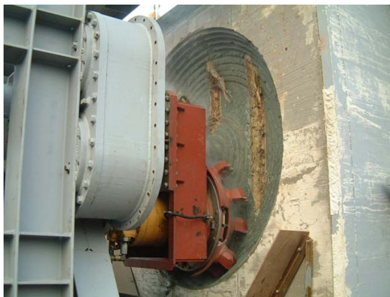
硬質地盤掘削性能確認実験状況
