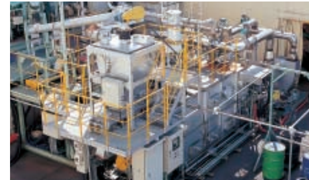
下水汚泥から、吸着能力を有した付加価値の高い活性炭化製品を製造することができる「汚泥活性炭化設備」
