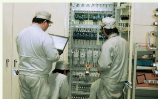
熱処理のプロがプロセスを検討し、冷却水の循環量を最適化。電力使用量を70%削減した。
