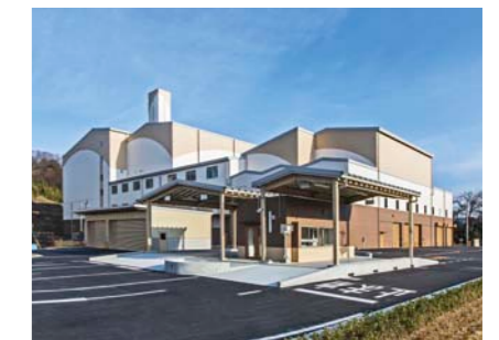
松阪市ごみ処理基盤施設整備事業
