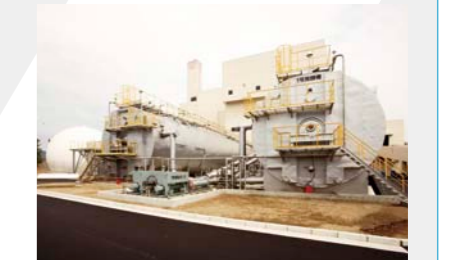
バイオガス化施設 発酵槽外観
