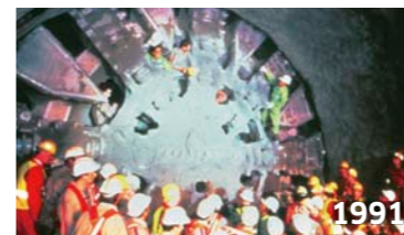
1991 英仏海峡海底鉄道トンネル掘削機、掘削に成功
