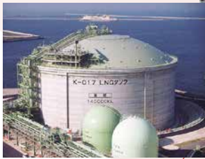
大阪ガス泉北 PCLNGタンク (96年完工)
