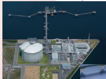
坂出LNG LNG受入基地 (10年完工)
