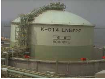
大阪ガス姫路 金属二重殻LNGタンク (86年完工)
