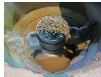
歯板は消耗品です。メンテナンス時は、上部フレームを取り外し、交換作業を行います
