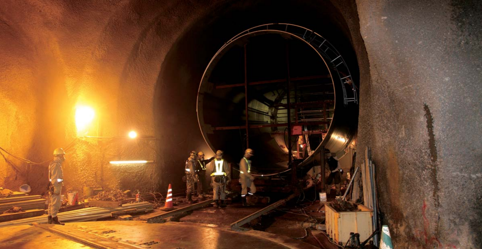
上部水圧鉄管(内径5.0m)の据付工事状況。手前にターンテーブルが見える。
