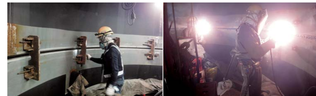
立坑内に吊り降ろされた水圧鉄管はしっかりと接合(左)した後、溶接士の中でもひととき優れた技能者が溶接作業を行なった(右)。その大半が内面からの片面溶接という極めて難しい溶接である。
