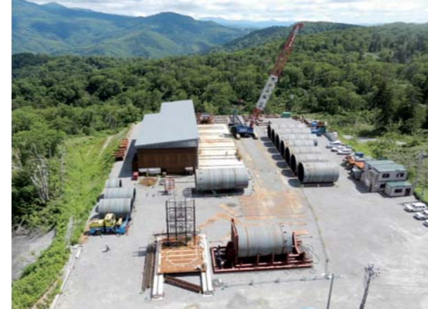
(左)仮工場全景。播磨工場から半割管の状態運んだ水圧鉄管をここで円筒形に仕上げ、さらに3つあるいは4つをつなぐ作業などを行なった。 (右)京極発電所の建設現場。冬は積雪が5mにも達する豪雪地帯だが、川崎重工が担当した水圧鉄管工事は冬期(2011年12月～2012年1月)にも屋外作業を敢行した。
