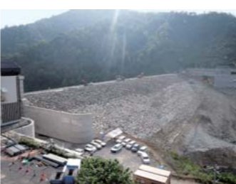
総貯水容量約555万m 3 の中央土質遮水壁型フィルダム。
