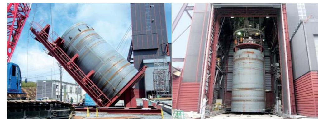
立坑部水圧管路の据付工事。まず、鉄管を3つないだ長さ約10mの水圧鉄管を立起し(左)て立坑入口に移動し、天蓋で吊り下げて立坑内にゆっくりと降ろした(右)。
