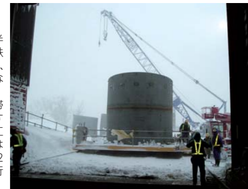
(左)仮工場全景。播磨工場から半割管の状態運んだ水圧鉄管をここで円筒形に仕上げ、さらに3つあるいは4つをつなぐ作業などを行なった。 (右)京極発電所の建設現場。冬は積雪が5mにも達する豪雪地帯だが、川崎重工が担当した水圧鉄管工事は冬期(2011年12月～2012年1月)にも屋外作業を敢行した。
