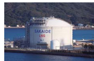
●陸上のLNGタンク 海上輸送されてきたLNGは陸上のLNGタンクに揚荷され、貯蔵される。
