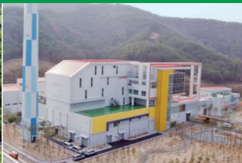
●韓国「亀尾」市MSWIP 1日のごみ焼却能力：200t（100×2炉） 発電能力：2,940kW 竣工：2010年12月
