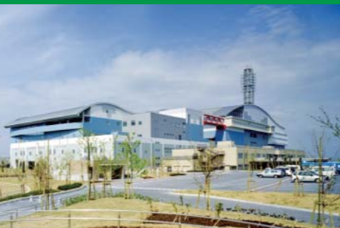
●岸和田市貝塚市クリーンセンター 1日のごみ焼却能力：531t（177×3炉） 発電能力：1万2,000kW 竣工：2007年3月
