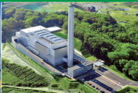
●枚方市東部清掃工場 1日のごみ焼却能力：240t（120×2炉） 発電能力：4,500kW 竣工：2008年12月
