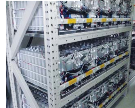
風力発電所(上はイメージ写真)の「電力安定化装置」に組み込まれた「ギガセル」(株)ウインドパワー・西目風力発電所)。
