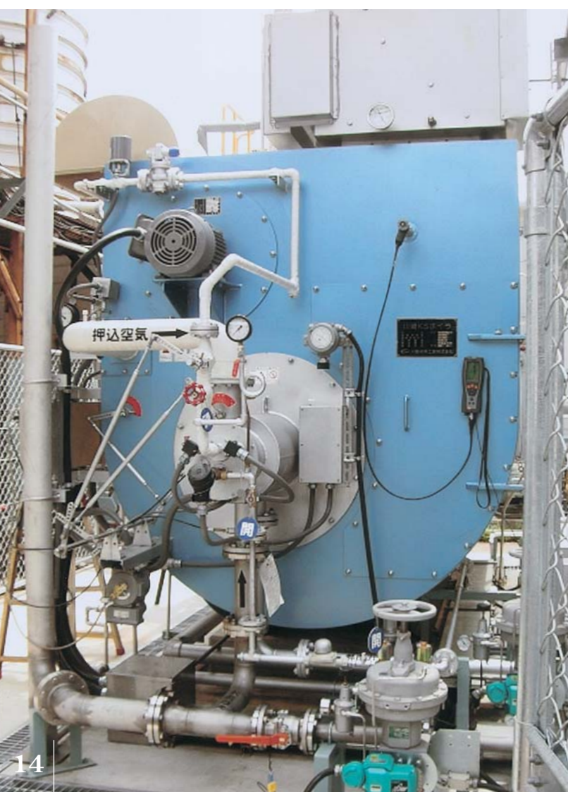
←南海化学工業（株）小雑賀工場に納入された本システムの第一号機。 ↓同工場では年間約436万m 3 の副生水素を有効利用することで、年間約109万m 3 Nの天然ガス使用量と同約2,500tのCO 2 が削減できることになった。
