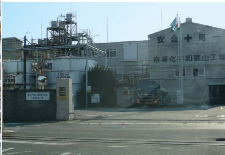
←南海化学工業（株）小雑賀工場に納入された本システムの第一号機。 ↓同工場では年間約436万m 3 の副生水素を有効利用することで、年間約109万m 3 Nの天然ガス使用量と同約2,500tのCO 2 が削減できることになった。
