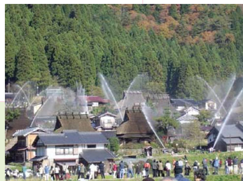
火に弱い茅葺き屋根の家を守るため、集落には62基の放水銃が設置されている。5月と11月に器具の点検などのため行なわれる一斉放水は、観光客に人気のイベントとなっている。(写真提供/南丹市役所美山支所)
