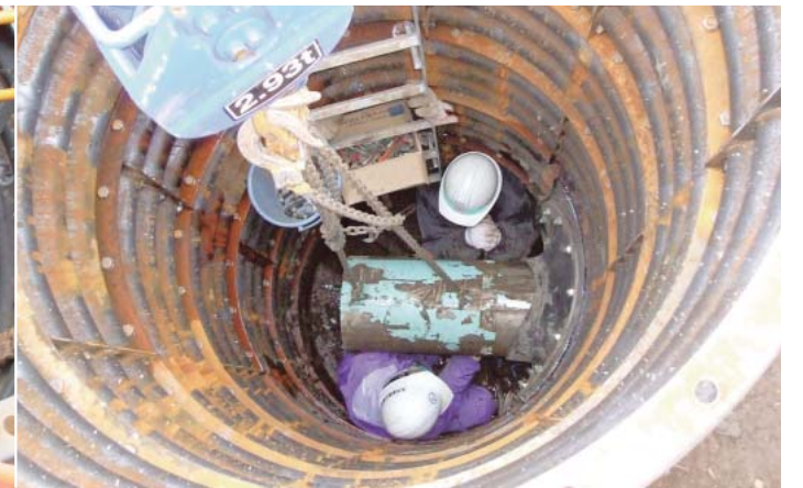
到達部の立坑で到達した掘進機を回収している場面。実証実験では、直線150mの長距離推進で到達精度の誤差は数mmだった。
