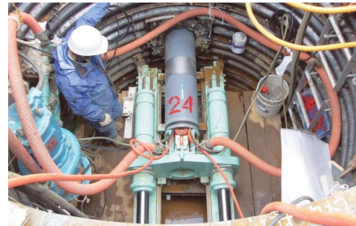
発進部の立坑(地表から縦に掘った作業用の穴)。ここから、掘進機が掘り進むトンネルに塩化ビニール管を押し入れていく。
