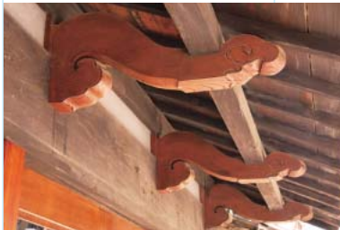
商家の軒の出桁を支える海老状に曲がった腕木には彫刻が施されている。
