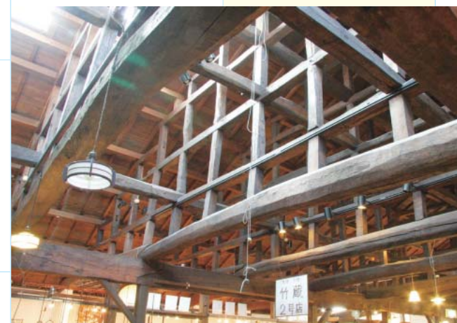
赤瓦1号館(醤油仕込蔵)の天井は、和小屋造りという伝統的な様式で組まれている。
