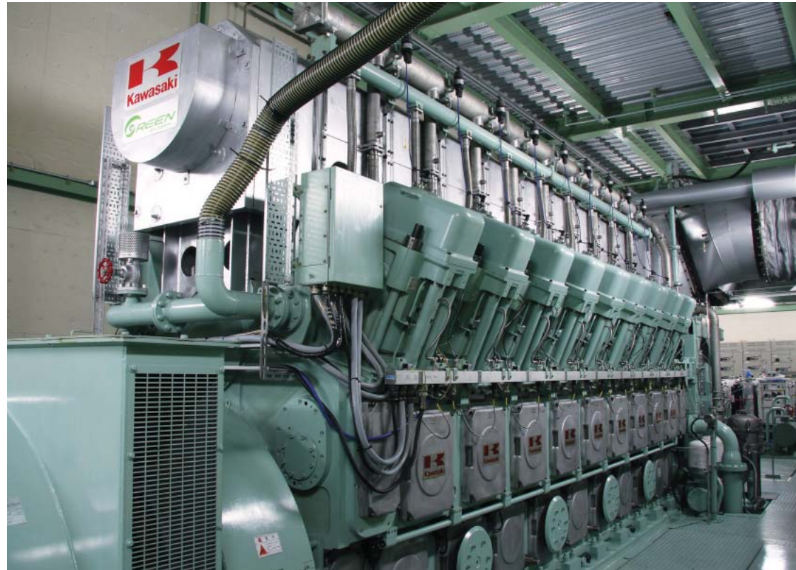
世界最高の発電効率を維持しつつ実証運転中の「カワサキグリーンガスエンジン発電設備」の実証プラント。
