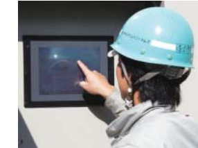
●コントロールパネル ワンタッチで起動、停止ができるので、運転員に特別な訓練は必要ない。
