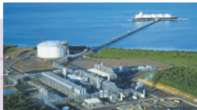
LNG carrier moored to a pier at an LNG liquefaction terminal (photo by Tokyo Gas Co., Ltd.)
