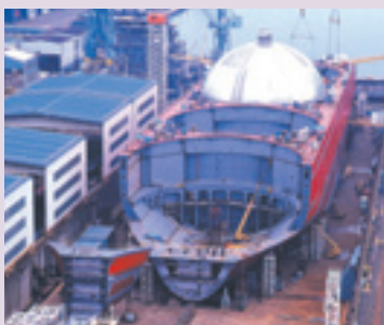
LNG carrier under construction
