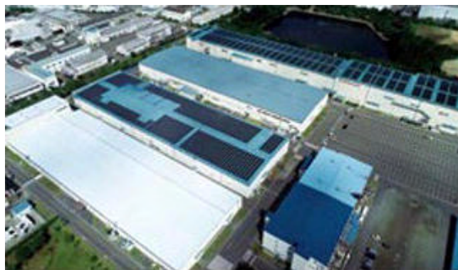
西神工場 728kW発電設備
