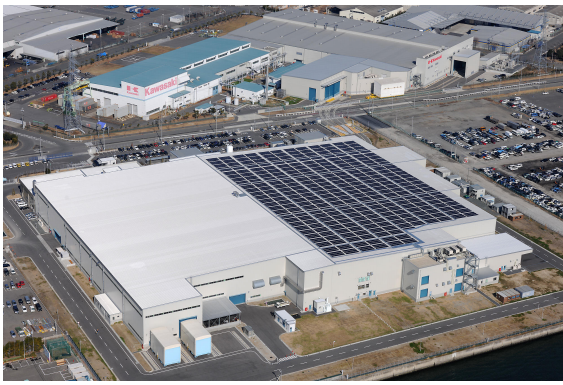
名古屋第一工場 750kW発電設備
