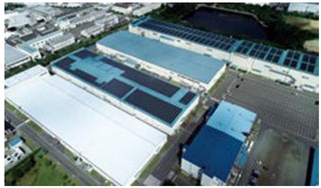
西神工場 728kW発電設備
