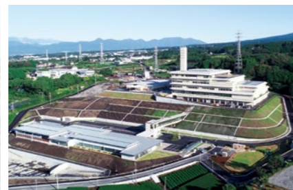
ごみ焼却プラント
