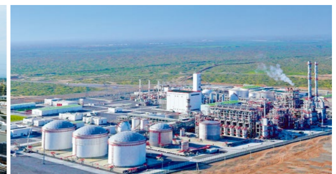
ガス・ター・ガソリン(GTG)プラント
