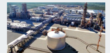
2014 トルクメニスタン最大のアンモニア・ 尿素肥料製造プラント完工
