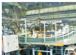
播磨工場での9%Ni鋼タンク側板の自動溶接
