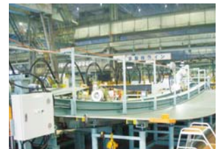
播磨工場での9%Ni鋼タンク側板の自動溶接
