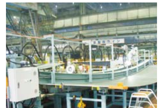
播磨工場での9%Ni鋼タンク側板の自動溶接
