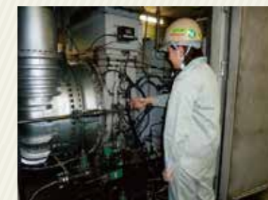
ガスタービンの定期メンテナンス
