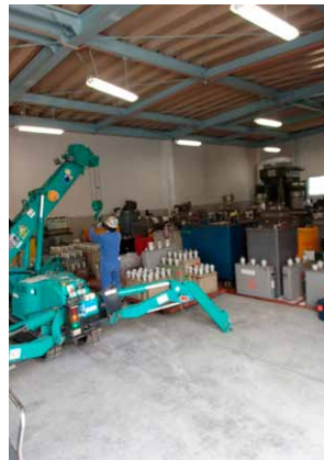
PCB排出作業状況
