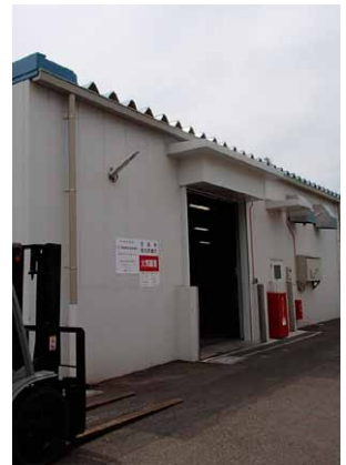
PCB保管倉庫
