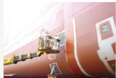
高所作業車を使った船舶の溶接検査
