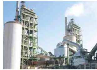
セメント排熱発電設備
