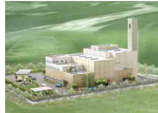
ごみ焼却処理施設
