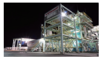
実証運転を行った水素液化機
