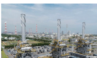
100MW級コンバインドサイクル発電プラント
