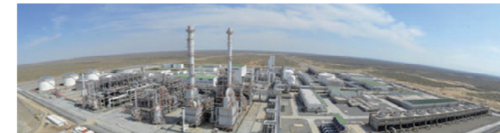
ガス・ター・ガソリン(GTG)プラント
