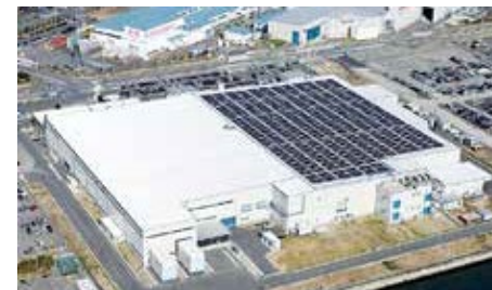
図14 名古屋第一工場 750kW発電設備
