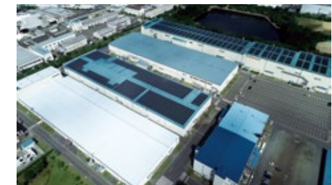
図15 西神工場 728kW発電設備
