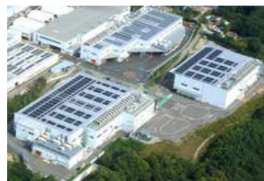
図14 西神戸工場927kW発電設備 (うち422kWはFITによる販売)
