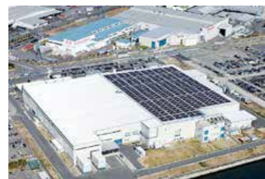
図13 名古屋第一工場 750kW発電設備
