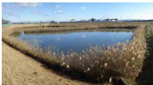
図19：調査したため池
