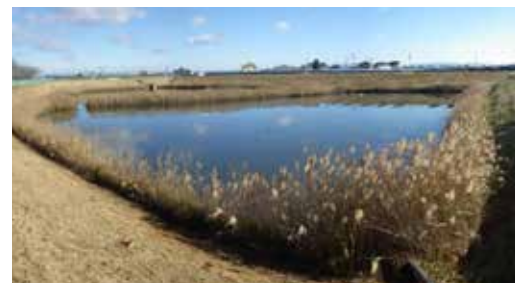
図19：調査したため池
