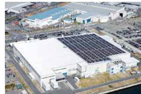
図9：名古屋第一工場 750kW発電設備
