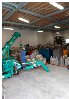
PCB排出作業状況
