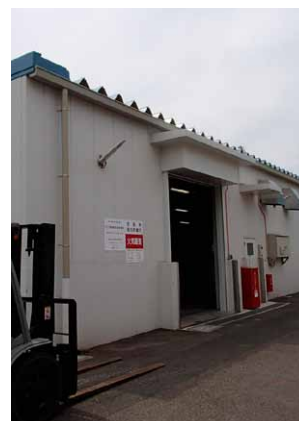
PCB保管倉庫
