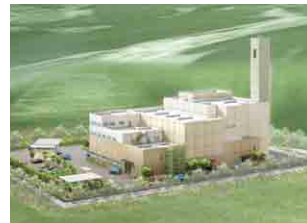
ごみ焼却処理施設
