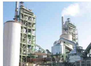
セメント排熱発電設備
