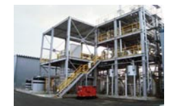
バイオエタノール製造実証プラント
