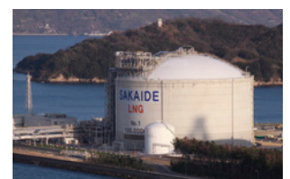
坂出LNG基地
