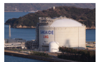
坂出LNG基地
