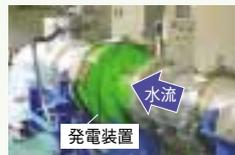
配管にセットされた発電装置(40kW)
