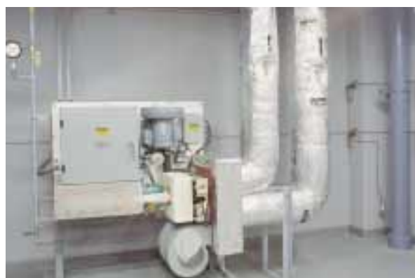
模擬煙発生装置
