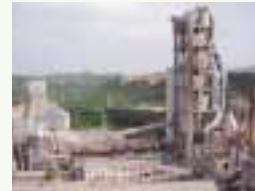
セメント排熱発電設備
