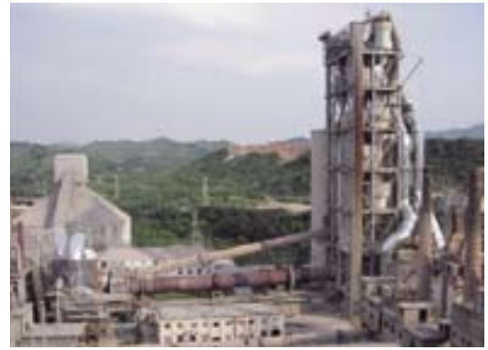
セメント排熱発電設備
