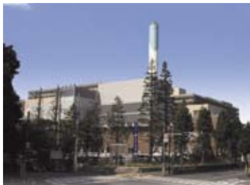
流動床ガス化溶融式ごみ焼却プラント
