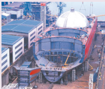
建造中のLNG運搬船
