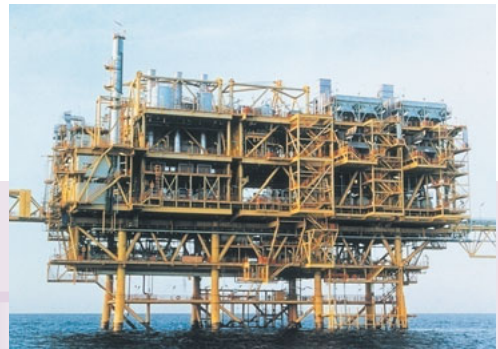
洋上に設置されたガスコンプレッションモジュール
