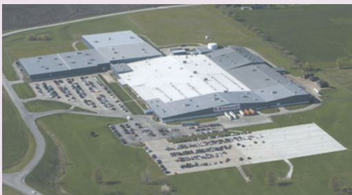
KMM メアリービル工場
