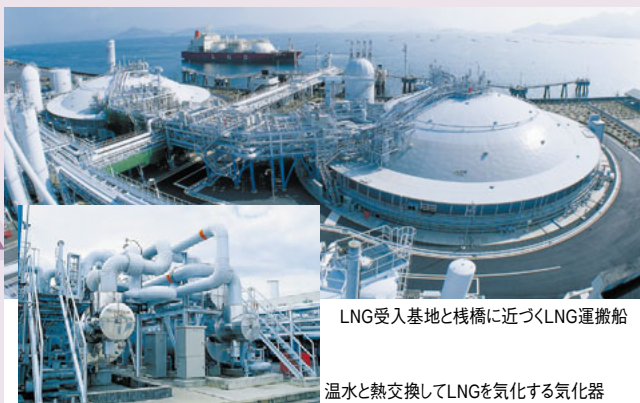
温水と熱交換してLNGを気化する気化器
