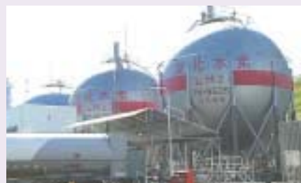
H- ロケット「液化水素貯蔵供給所」
