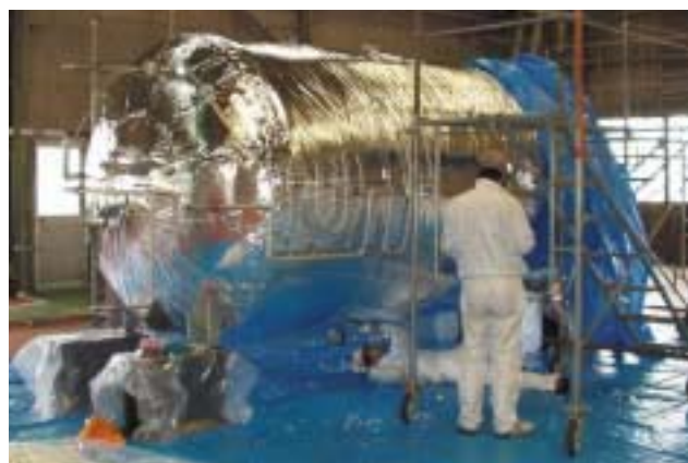
断熱材の施工
