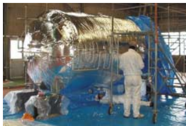
断熱材の施工
