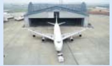
大型航空機用消音ハンガー
