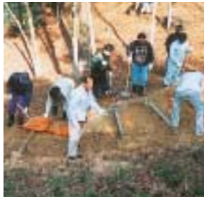
兵庫県「やしらの森公園」の整備
