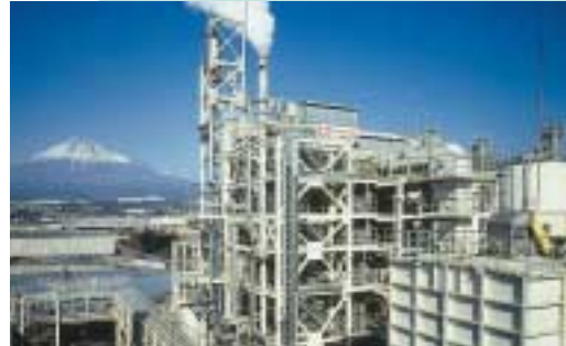
RPFを燃料にした廃棄物発電設備 製紙スラッジ330t/日、RPF50t/日の処理量は国内最大規模
