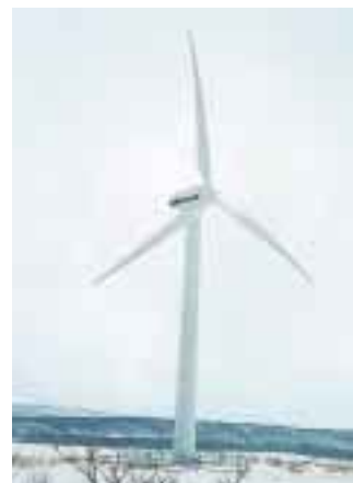
風力発電設備
