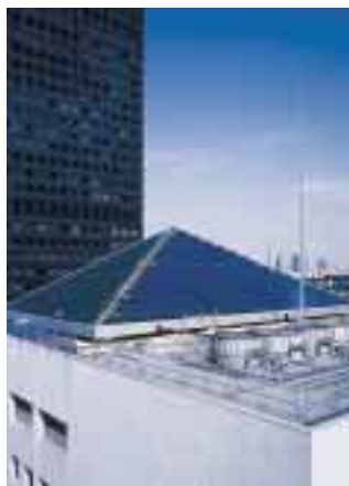
太陽光発電設備
