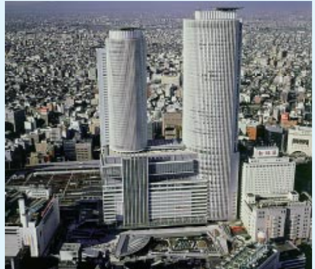
省エネ型地域冷暖房設備[ JR名古屋駅周辺地区 ]
