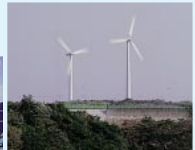
風力発電設備
