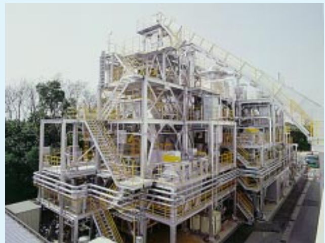
高効率熱回収ごみ焼却設備 [流動床ガス化溶融炉・実証試験設備]
